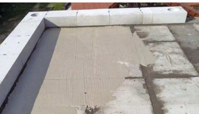
**SAVJET** - Ytong strop je učinkovito i brzo rješenje kod gradnje svih vrsta objekata i od iznimne je važnosti, kada smo u stisci s vremenom i nedostatkom prostora. Zbog jednostavne ugradnje koja se odvija bez izvođenja zahtjevnih oplata, Ytong strop je primjeren i za samostalne graditelje.
