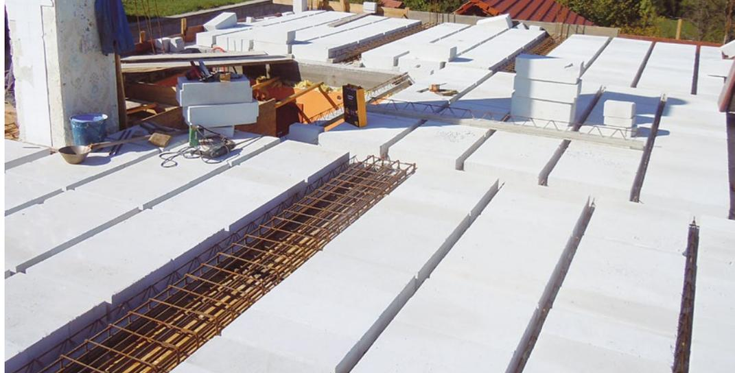
3. Armiranje uzdužnih i poprečnih rebara te horizontalnih serklaža: poprečna rebra armiramo armaturnom šipkom fi 10 mm u svaku zonu, uzdužna rebra sukladno sa statičkim izračunom dodatno armiramo u gornjoj ili donjoj zoni. Horizontalne serklaže izvodimo u Ytong elementima, čija armatura mora biti povezana s armaturom U vilica s uzdužnim i poprečnim rebrima. Na uglovima konstrukcije moramo armaturu usidriti iz obje horizontalne veze s armaturom vertikalnih serklaža.
